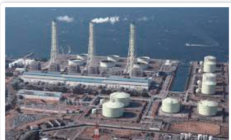
●発電所設備(水力・火力・原子力)
